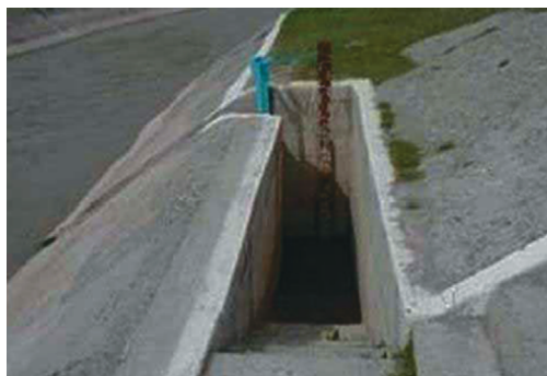
Рис. 1. Успокоительный колодец с уровнемерной рейкой [4]
