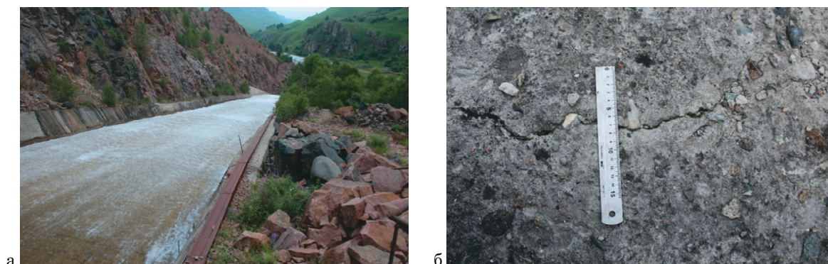
Рис. 1. Обследование паводкового консольного водосброса:
