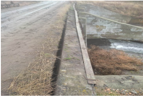
б) сдвиг железобетонной плиты переезда водосбросного сооружения со стороны нижнего бьефа, износ гидрогасителей консоли быстротока и подмыв основания консоли с оголением железобетонных свай
