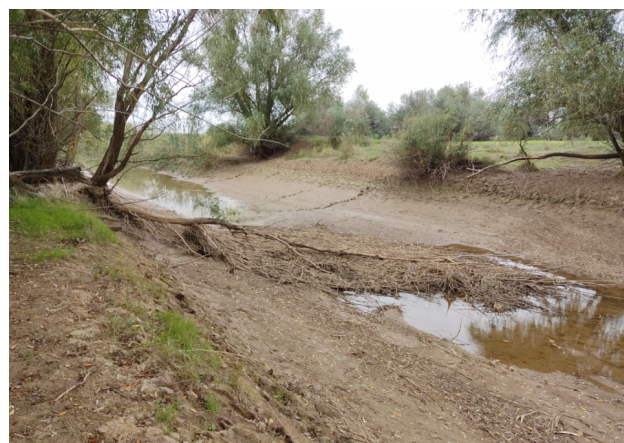
Рис. 1. Заиливание профиля канала
