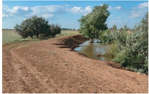
**Рис. 2. Места зарастания профиля канала, а также обрушивания откосов вследствие использования канала в качестве водопоя для крупного рогатого скота**
