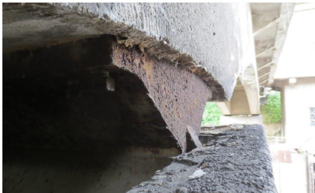
Рис. 8. Поверхностная коррозия опорных элементов (фото Б.А. Бондарева)
