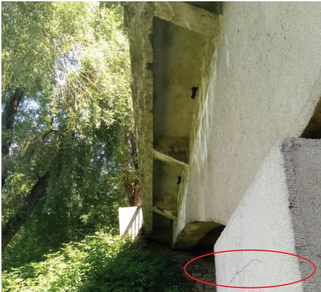
Рис. 5. Горизонтальная трещина опоры в результате морозного разрушения левой консоли 1-й балки у правого устоя (фото Б.А. Бондарева)
