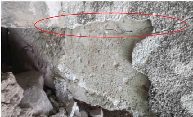
Рис. 6. Горизонтальная трещина до 1 мм в нижнем поясе балки № 2 в растянутой зоне в пролете 2 (фото Б.А. Бондарева)
