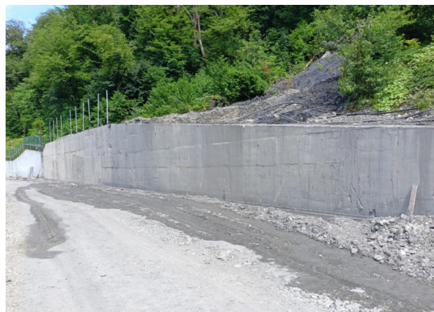
Рис. 7. Подпорная стена
