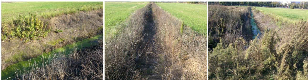
Рис. 2. Состояние каналов мелиоративной осушительной сети до очистки
