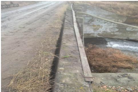
б) сдвиг железобетонной плиты переезда водосбросного сооружения со стороны нижнего бьефа,
