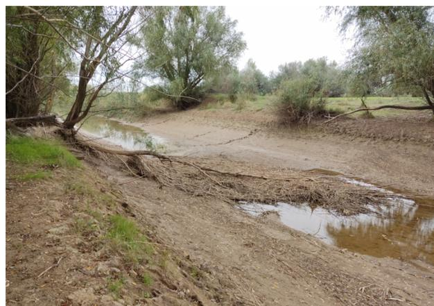
Рис. 1. Заиливание профиля канала
