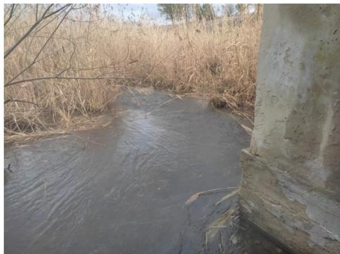
в) зарастание подводящего канала водосбросного сооружения и заиленность дна быстрого тока
