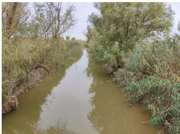
Рис. 4. Интенсивное зарастание откосов канала
