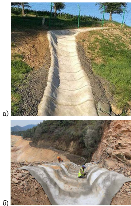
Рис. 3 а, б. Использование покрытия «Полотно бетонное марки BeNotex SK» для укрепления каналов, дорожных кюветов [2]
